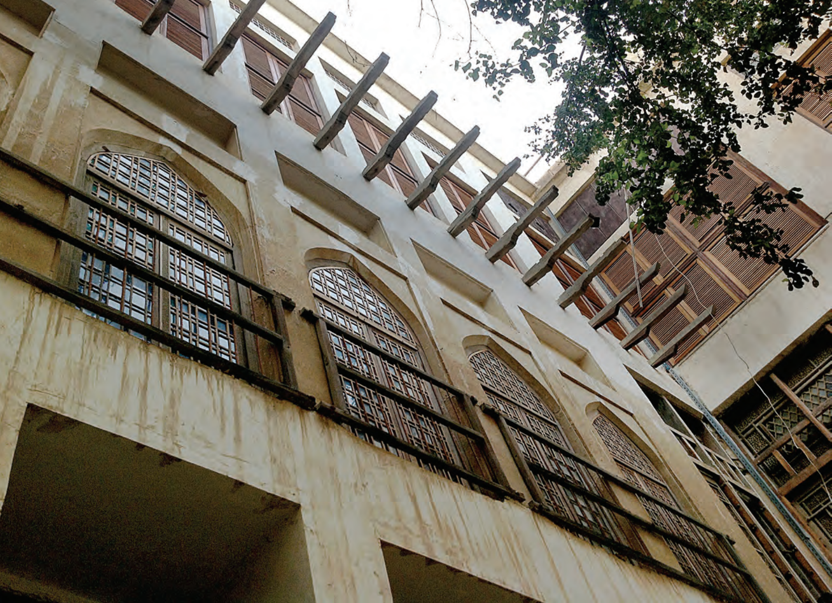
عمارت دهدشتی در بوشهر
