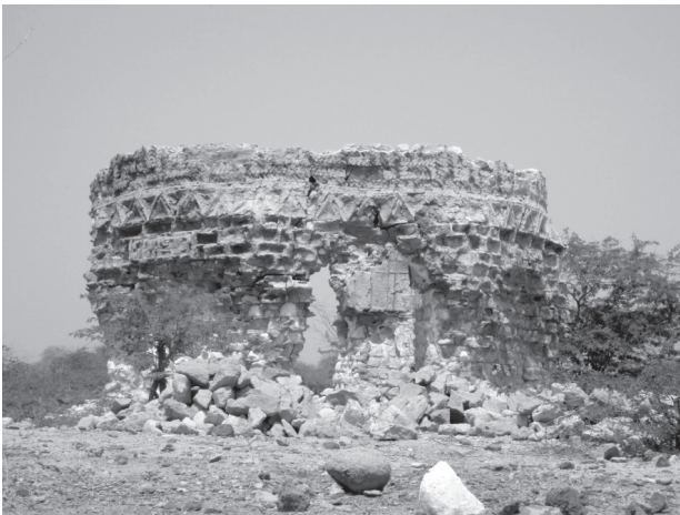
تصویر ۱۴. چهارطاقی شماره ۳ از مجموعه چهارطاقی‌های هرمز
