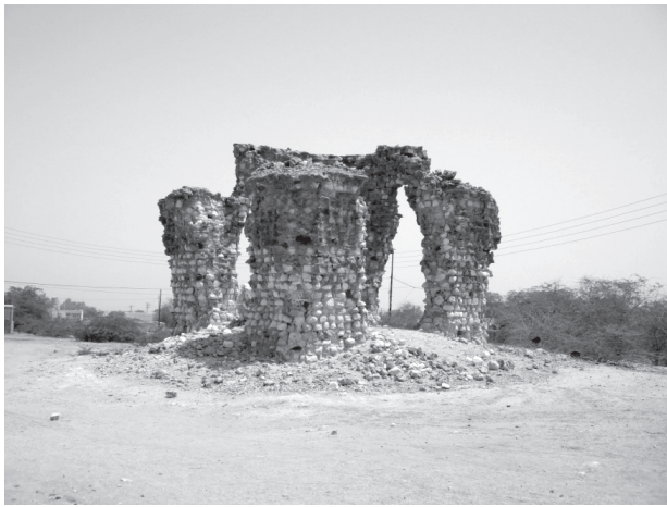
تصویر ۱۲. چهارطاقی شماره ۱ از مجموعه چهارطاقی‌های هرمز
