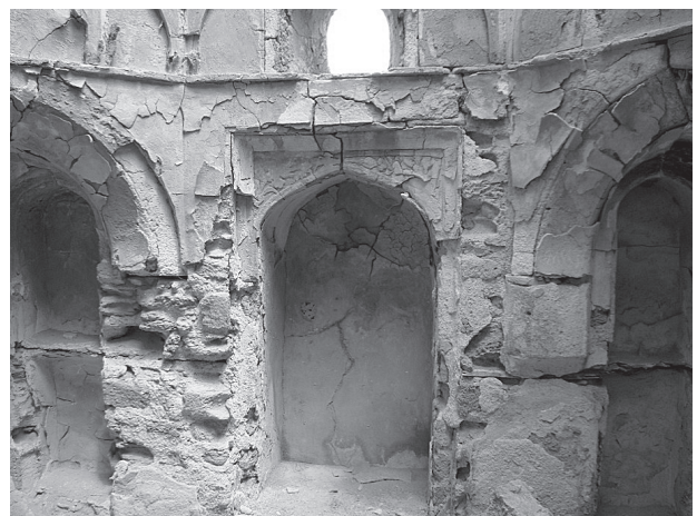
تصویر ۲. طاق‌نماهای تزئینی در ضلع شرقی مقبره بی‌بی تم‌سنتی
